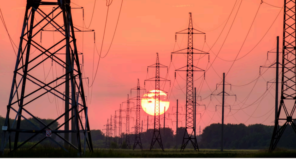
Silueta de un poste eléctrico durante el atardecer, Andrey Metelev
